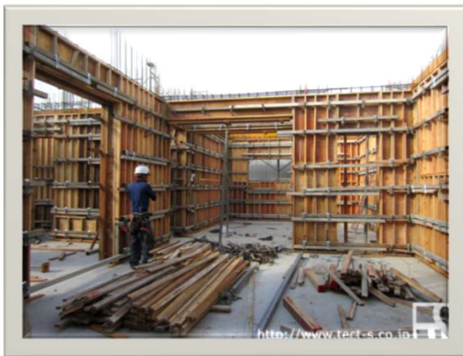
■在来型枠の施工風景
